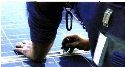
Panneaux solaires, pompes à chaleur les énergies renouvelables représentent un axe de croissance
